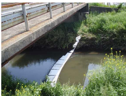
油類の流出対策（オイルマット設置）
