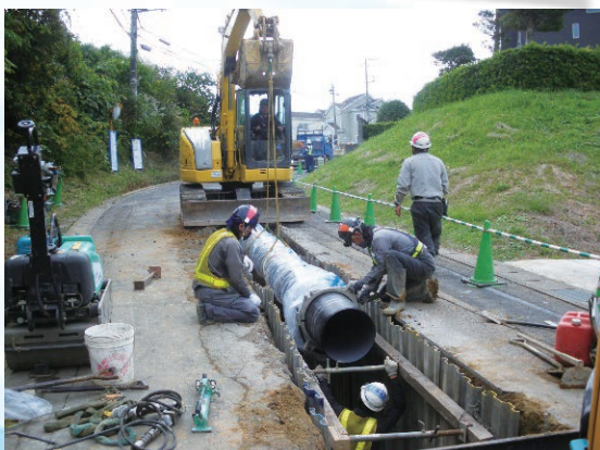
現在、佐倉市では地震に備えて、佐倉市水道施設耐震化計画に基づいて、水道管の耐震工事を行っています。
