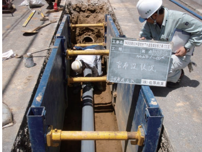
図5-9 下水道管の長寿命化工事
