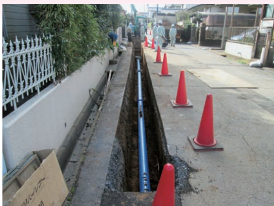
図5-5 水道管更新工事
