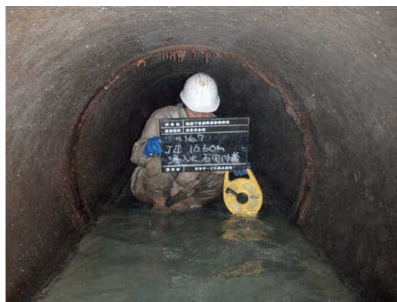
図5-2 下水道管点検調査
