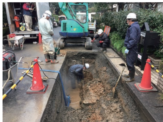
図5-1 水道漏水復旧工事
