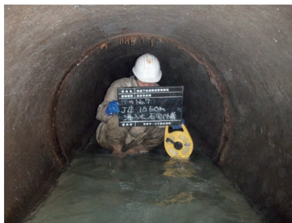
図5-2 下水道管点検調査
