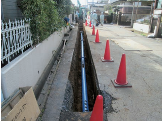
図5-5 水道管更新工事
