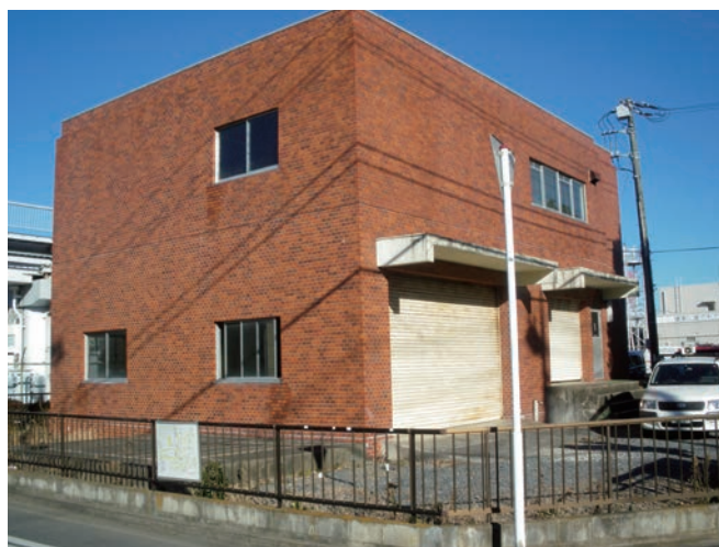
図5-10 耐震工事対象施設
