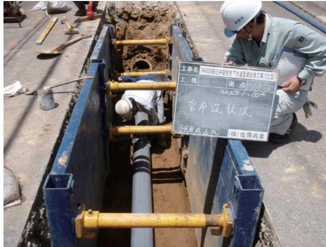
図5-9 下水道管の長寿命化工事
