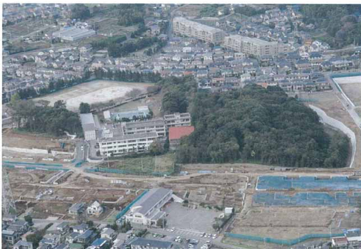
遺跡近景航空写真(平成19年)
