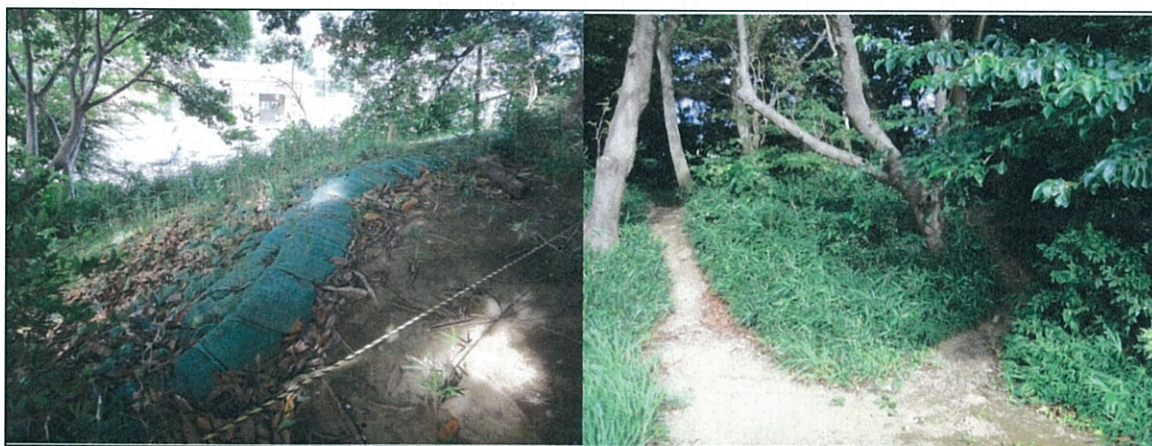
学校地区北側の崩落防止状況
