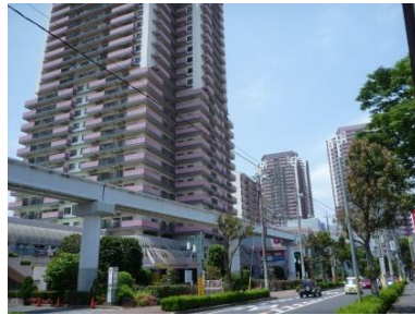
ユーカリが丘駅周辺 高層の共同住宅がランドマークとなっている
