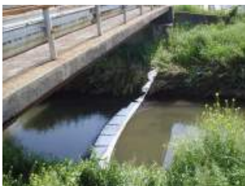
油類の流出対策（オイルマット設置）
