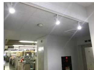
LED 照明 (本庁舎 1 号館)
