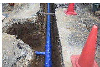
図2-25 水道管耐震化工事と耐震継手管の構造
