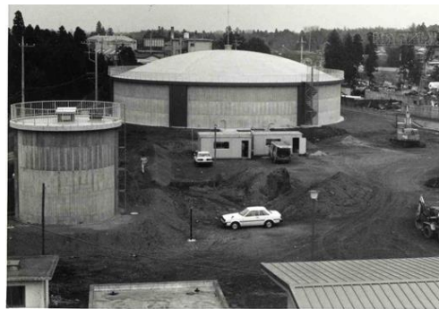
図2-2 完成間近の南部浄水場配水池
