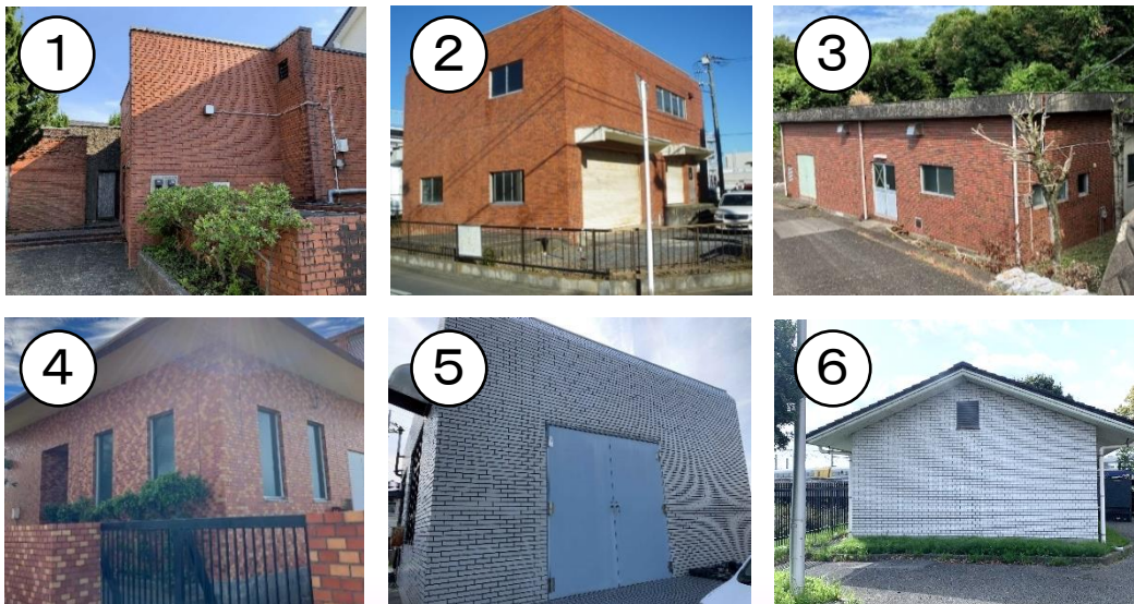
図2-17 下水道主要施設図と各中継ポンプ場の外観
