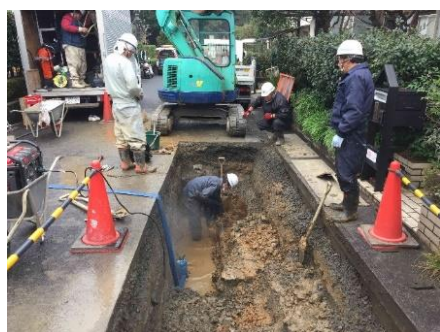
図4-10 水道漏水復旧工事
