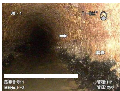
図4-12 TVカメラによる管渠調査
