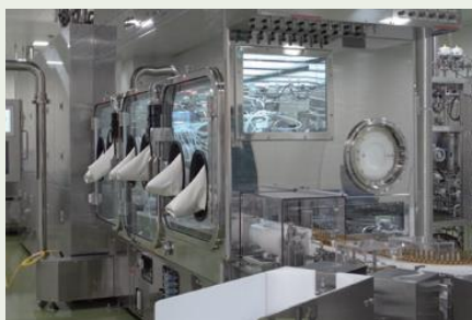
医薬品製造工場の建設
