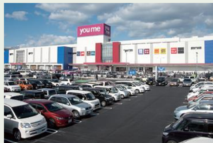
複合大型商業施設の建設
