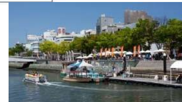
親水護岸の利用 (新町川/徳島市)
