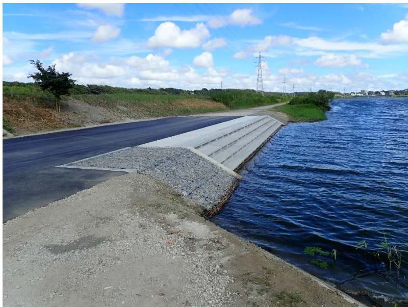
整備が終了した鹿島川護岸
