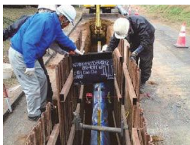
水道工事の様子
