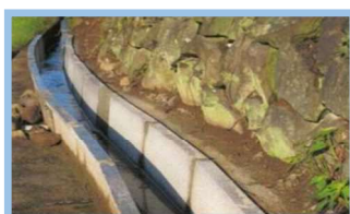
コンクリート水路の更新
