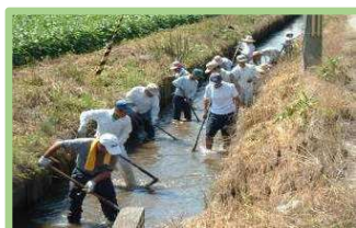
水路の泥上げ
