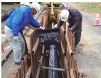
水道工事の様子。
