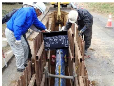
水道工事の様子
