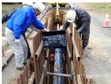
水道工事の様子
