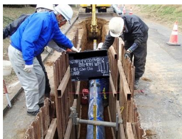
水道工事の様子
