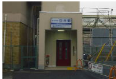
京成臼井駅北口エレベーター設置
