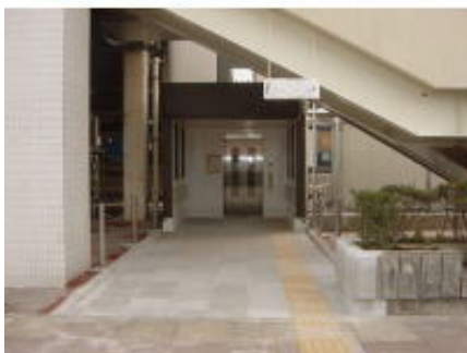
JR佐倉駅北口エスカレーター、エレベーター設置
