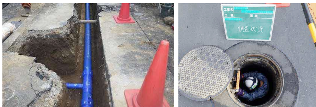
水道管の耐震化工事（左）／下水道の調査（右）
