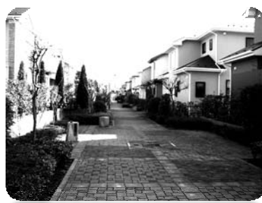
地区計画が定められた住宅地
