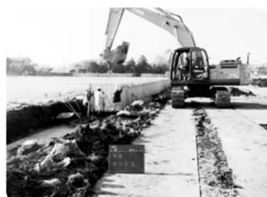
雨水排水整備
