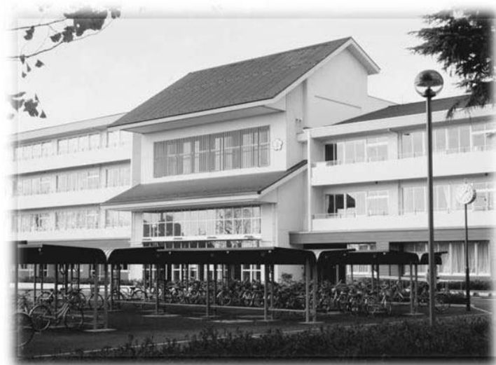
耐震化改築工事施工後の佐倉中学校 校舎
