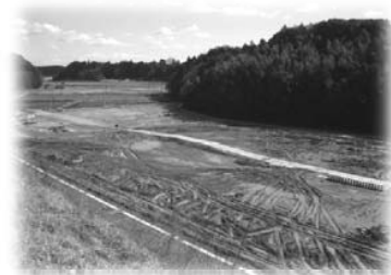
造成中の多目的球技場 (岩名運動公園)
