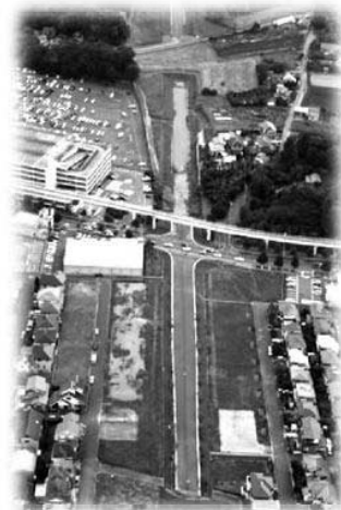
現在整備中の都市計画道路 井野酒々井線外1路線
