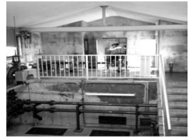
下水道ポンプ場
