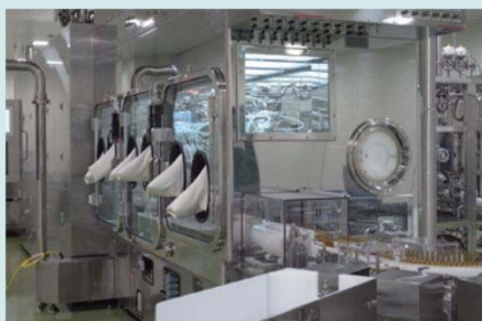
医薬品製造工場の建設
