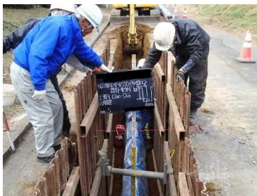
水道工事の様子
