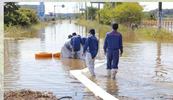
令和元年10月25日の大雨により冠水した道路
