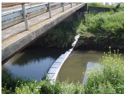
油類の流出対策（オイルマット設置）
