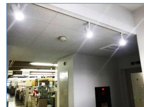
LED照明 (本庁舎1号館)
