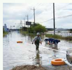
令和元年10月の大雨で冠水した国道296号 (鷹匠橋～鹿島橋・令和元年10月26日撮影)
