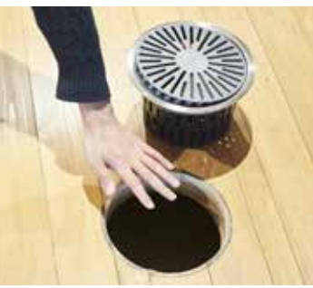
オフィスにはいたるところに地下水を利用したヒートポンプ空調の穴がある
