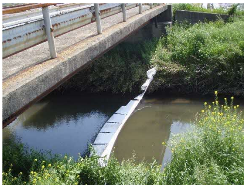
油類の除去対策（オイルマット設置）
