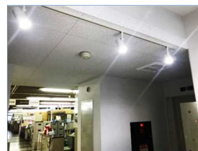
LED照明 (本庁舎1号館)
