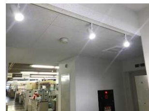
LED 照明 (本庁舎 1 号館)
