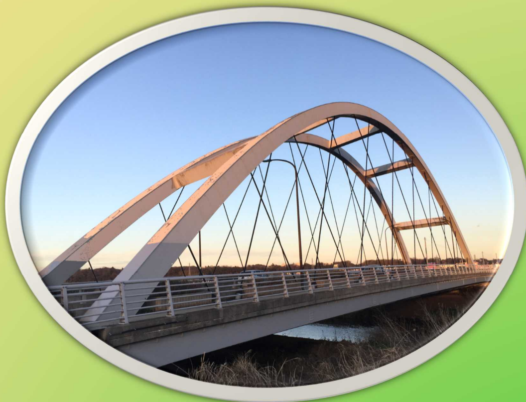
鹿島川大橋 2004年架設 77.0m
