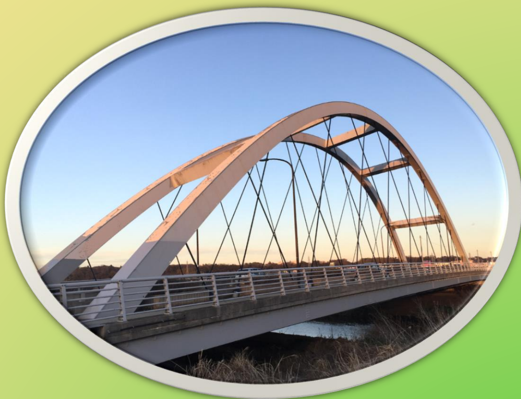
鹿島川大橋 2004年架設 77.0m
