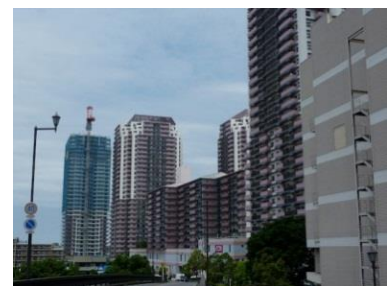
高層住宅が配置されている計画住宅地（ユーカリが丘）
