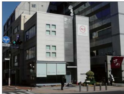
外壁の素材と調和し洗練されたデザインとした広告物の例（市外）
