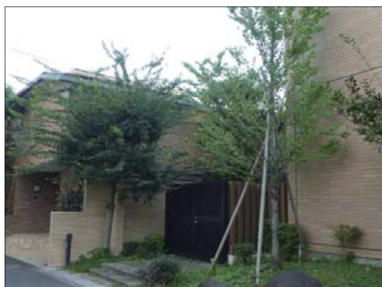
複数の建築物の外壁の色彩を暖かみのある落ち着いた色彩とした例（市外）
