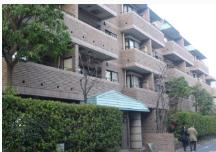
壁面に付けた凹凸に合わせて植栽を組み合わせる例（市外）
