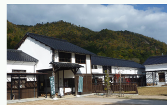
勾配屋根のリズムで、斜面緑地との調和を図っている例（市外）
