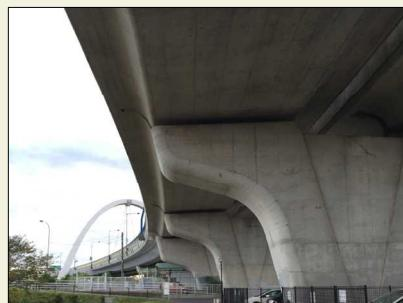
排水管を桁下～橋脚に設けたスリットに収納し、すっきりとした桁下となっています。（市外）
