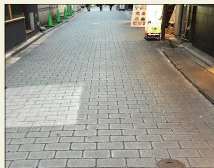
アスファルト舗装の表層に自然色塗装と、型押しにより石畳風の目地を施したもの。(市外)
