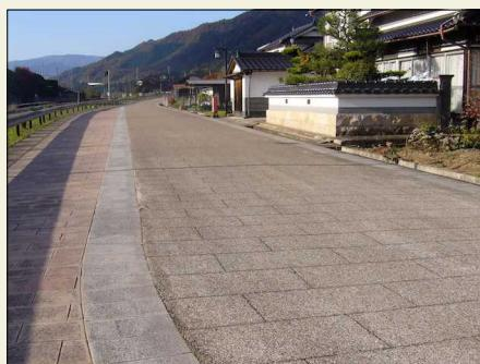
アスファルト舗装の表層に半たわみ性自然石骨材入りアスファルトを用い、カッターにより石畳風の目地をほどこしたもの。(市外)
