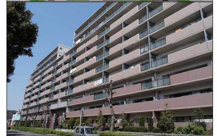
■写真 圧迫感を軽減した外壁(西志津)
