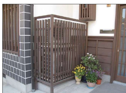
木材による囲いにより建築設備を修景した例
