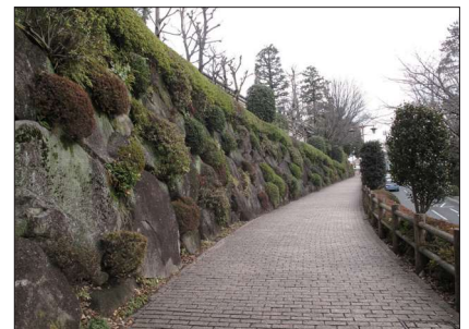
■写真 自然石積みと植栽の組合せにより、エイジングを楽しめるようにしている例（市外）
