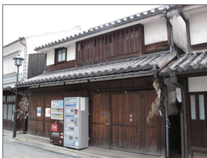
■写真 建物1階部に自動車の車庫を設け、木製の扉で修景し、まち並みの連続性を確保した例 (市外)
