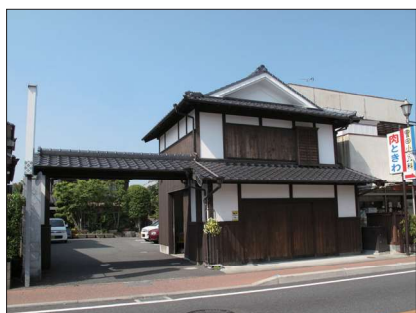
■写真 敷地の奥に駐車場を設け、沿道に伝統様式に配慮して門を設置した例 (市外)
