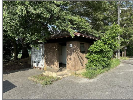
トイレ (田町駐車場)
