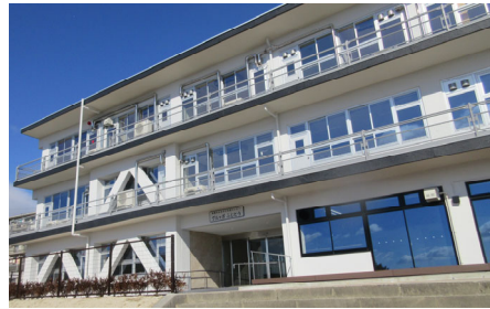
旧小学校施設をリノベーションした「グルッポふじとう」（高蔵寺ニュータウン）
