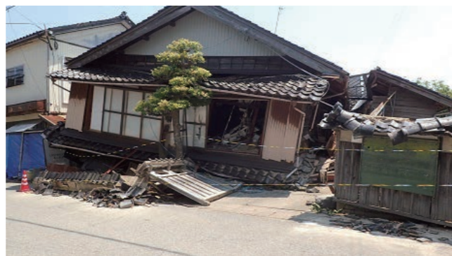
能登半島地震によって倒壊した家屋(内閣府・倒壊家屋写真)
