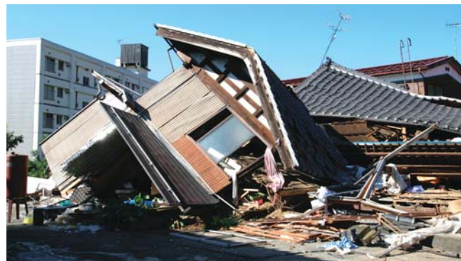
新潟県中越地震によって倒壊した家屋
