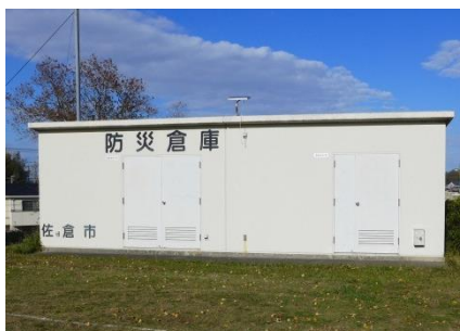
▲ 防災用備蓄倉庫
