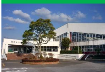
四街道市温水プール
