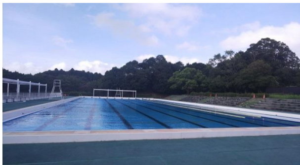
プール槽、プールサイドに大きな劣化は見られない
