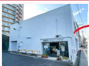
ヤングプラザ【築53年】
