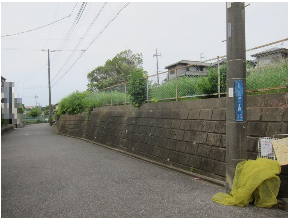
⑦ フェンス、その土台、間知ブロック等 電柱（道路）
