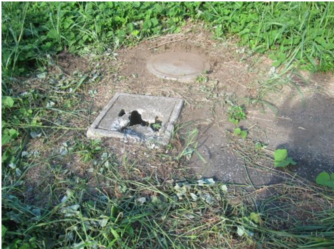
⑮ 雨水桝（蓋が破損）、汚水桝（敷地内）
